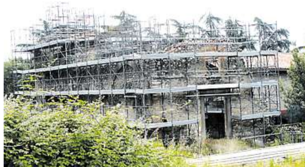
In attesa del restauro alla pieve di San Bartolomeo proseguono i lavori di messa in sicurezza del sito
