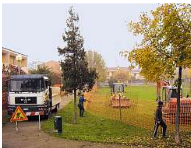
I lavori di posa della recinzione saranno ultimati entro Natale
