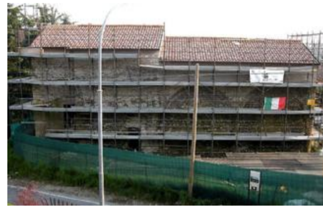
Impalcature alla Pieve: è partito il rifacimento del tetto
