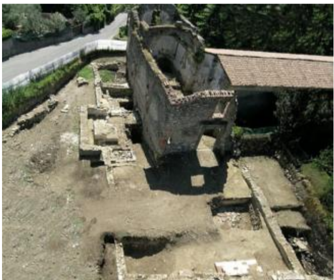
Ecco come appariva il sito prima dell'inizio dei lavori di conservazione
